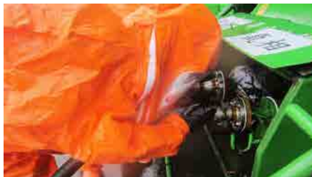
應變人員進行槽車裝卸管線銜接
